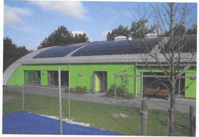
Abb1 — Kita Sandhäuschen: 29,9 kWp Anlagengröße; 30.835 kWh Stromertrag und 17.977 kWh eigener Stromverbrauch in 2023 •
